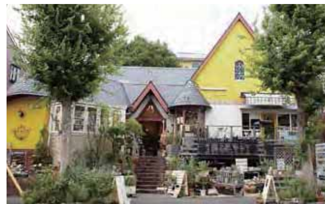
見た目可憐く、行き交う人を引きつける魅力あるLEADの外観。
