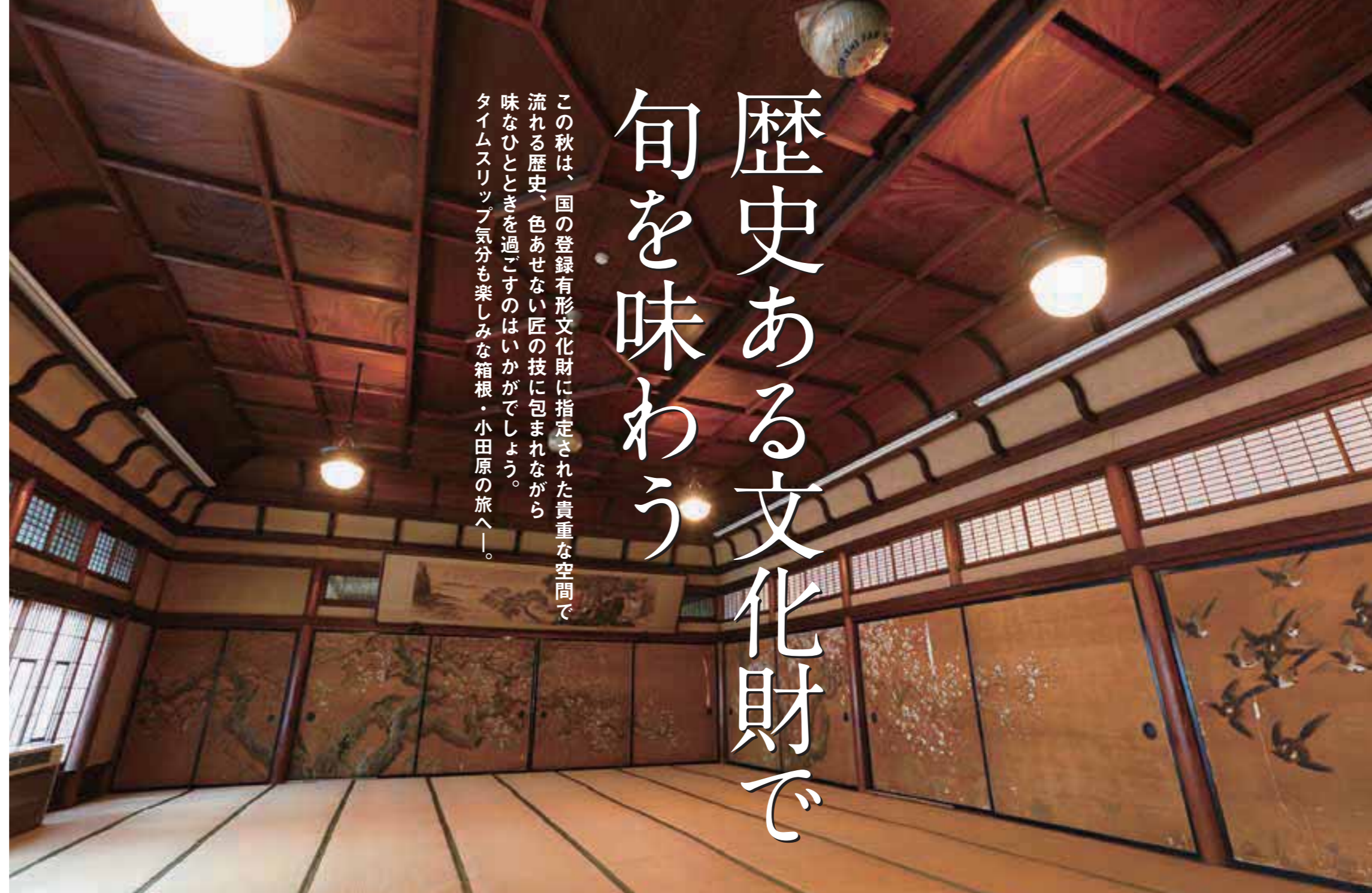
本館南棟4階、100畳大の大広間「神代閣」。総神代杉による二重折上げ格天井は圧巻。見事な襖絵は昭和初期の日本画家、仙田菱畝の作。大黒柱を用いない「総もたせ」という特殊な工法が使われている。
