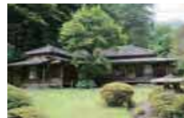
よく手入れされた庭と野鳥のさえずりを楽しみながら、料理をいただく(上)。明治時代に建てられた商家の離れ家を移築。屋根は棧瓦葺、寄棟造り。今後は、庭園でのライブ演奏も企画予定という(下)。
