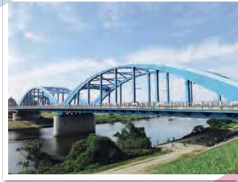
神奈川県川崎市と東京都大田区の間を流れる多摩川にかかる丸子橋。
