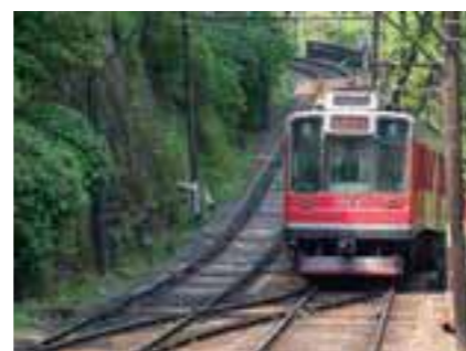
斜面を登るために導入されたスイッチバックのための線路。一時的に進行方向を変え、ジグザグ山を登っていく。
