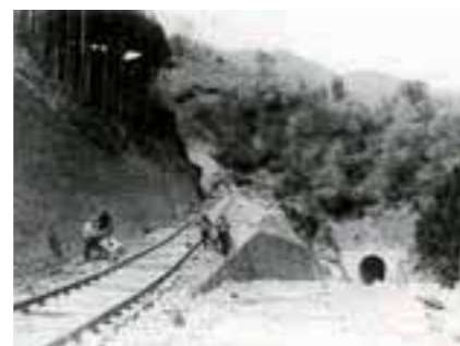
出山のスイッチバック線の工事の様子。自然を損なわずに敷設することを重視し、山ひだを縫うように軌道が引かれていった。(写真：下田組提供)
