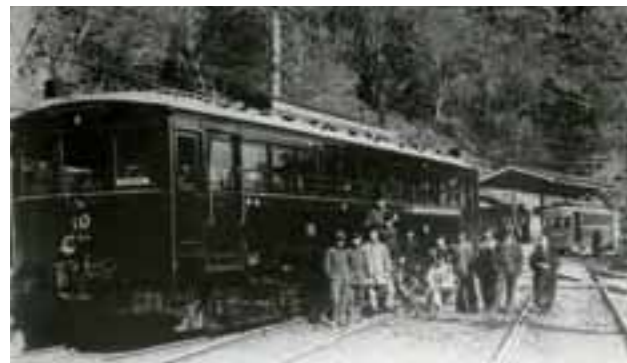
湯本駅に停車中の登山鉄道チキ2型10号(昭和2年製)。このころは木造車両、後に半鋼製車両が登場する。
