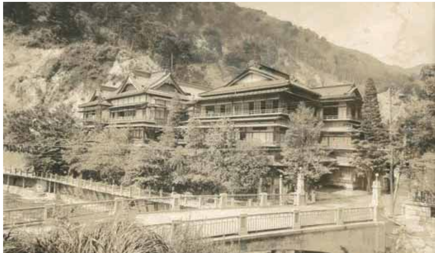
早川に臨む大正8年築の本館北棟。写真は完成当時のもの(撮影年不詳)。
