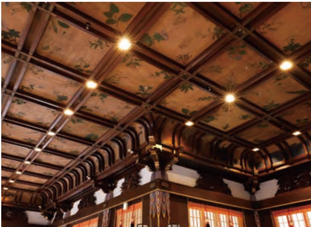
メインダイニングルーム・ザ・フジヤの折上げ格天井。日本アルプスの高山植物などが描かれ、風雅な雰囲気が漂う。
