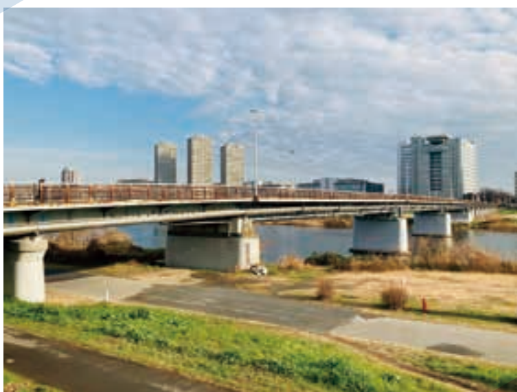
橋の下部には、2本の巨大なガス管が通っています。
