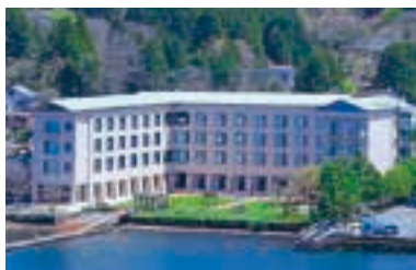
1992(平成4)年竣工の現在のホテル。
