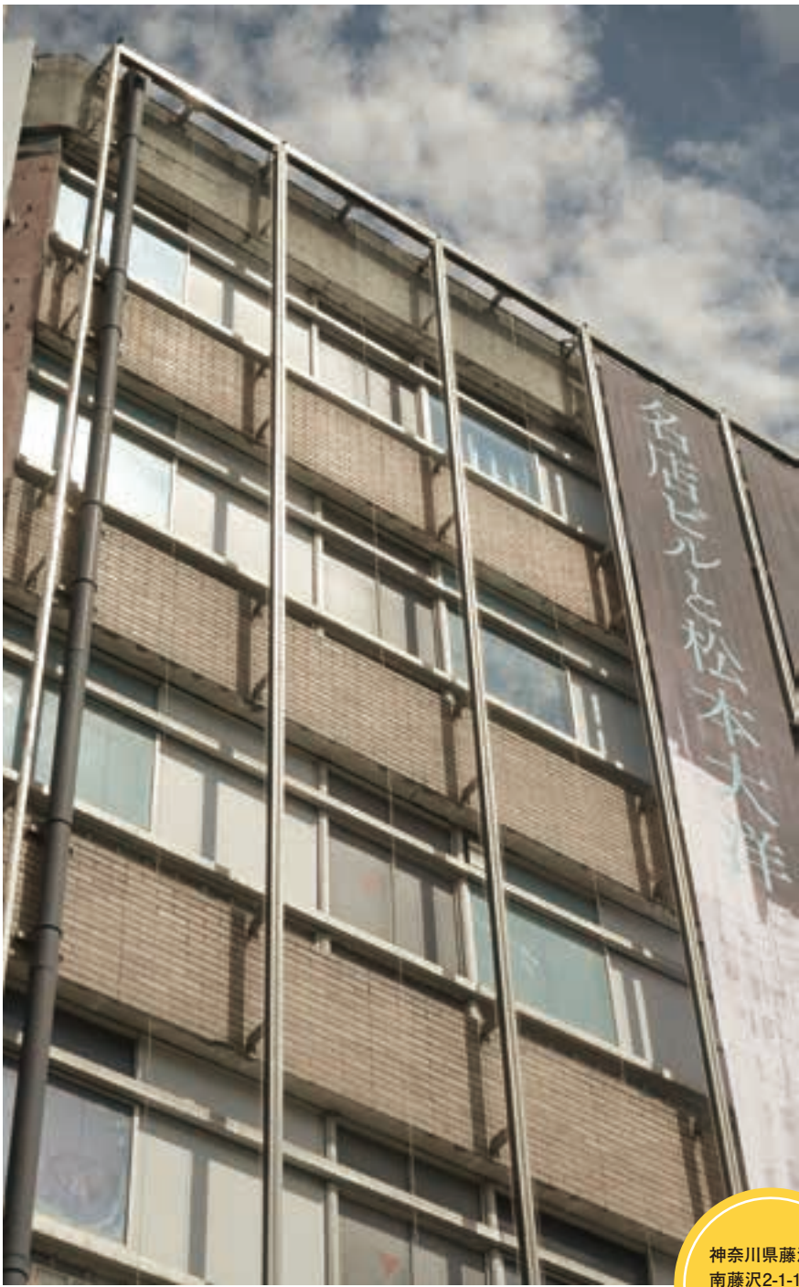
ビルの外観や内部にはレンガやタイルなどがあしらわれ、温かみのある懐かしい雰囲気が感じられる。往時はエレベーターガール・ボーイもいたそう。
